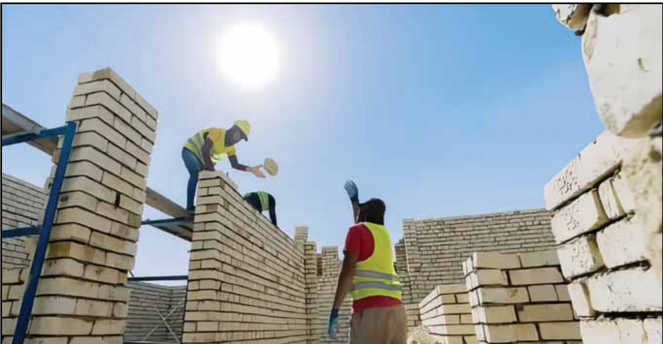
عمال بناء في إحدى المدن الجديدة ضمن مشاريع حل أزمة السكن
